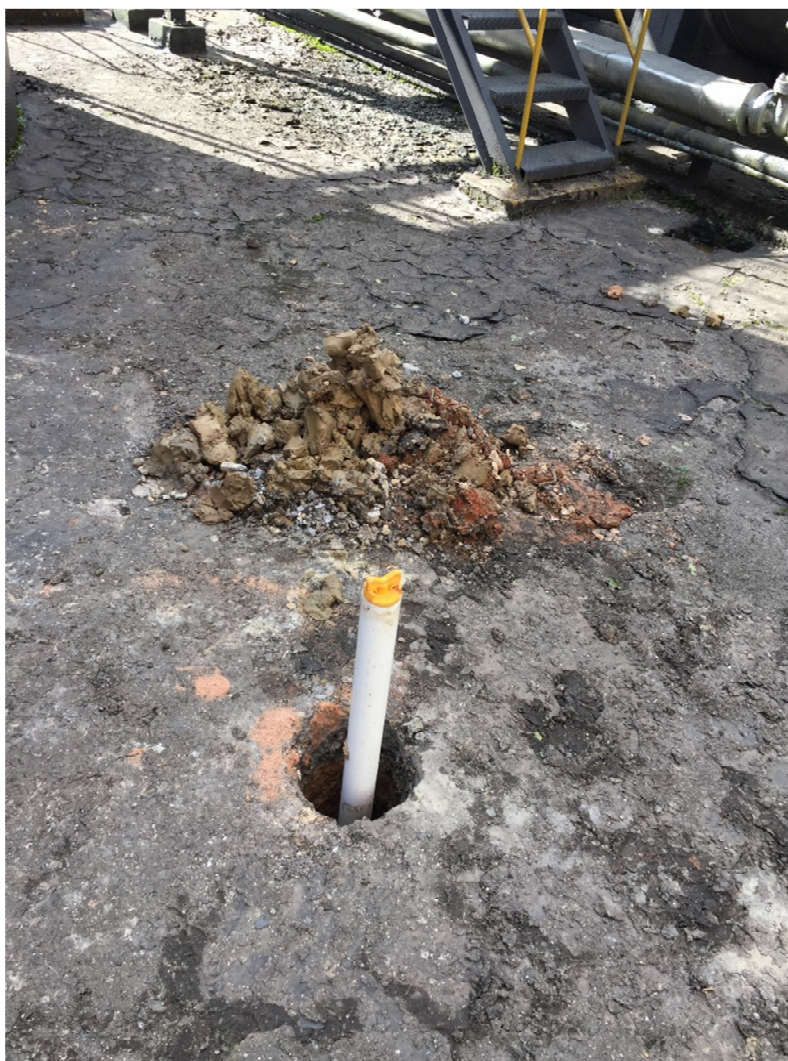
Figura 13. Aspecto visual do poço de monitoramento provisório instalado na STRATURA – PR.
