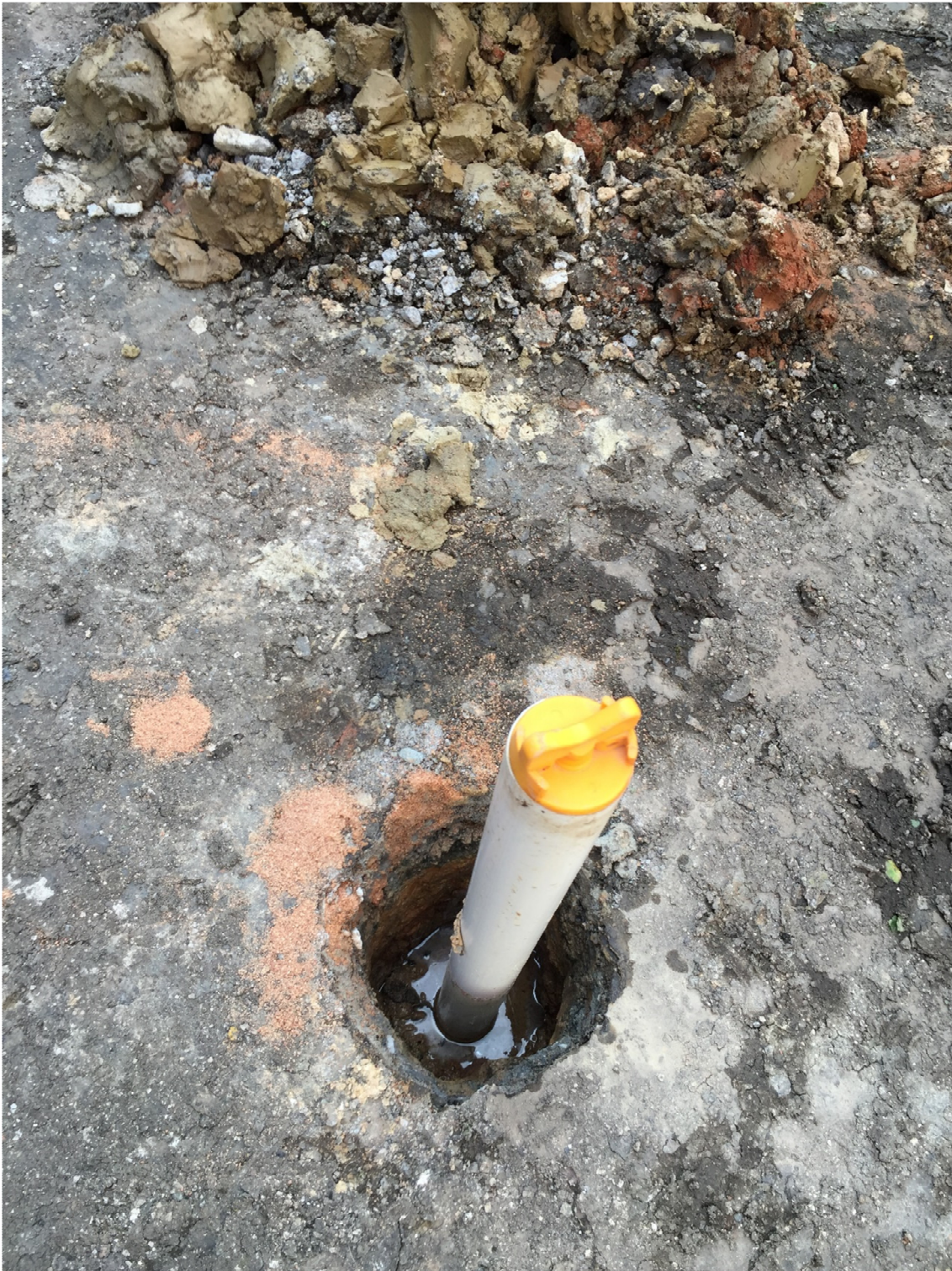
Figura 14. Aspecto visual do poço de monitoramento provisório instalado na STRATURA – PR, com destaque ao solo retirado da franja capilar e ao nível de água subterrânea.
