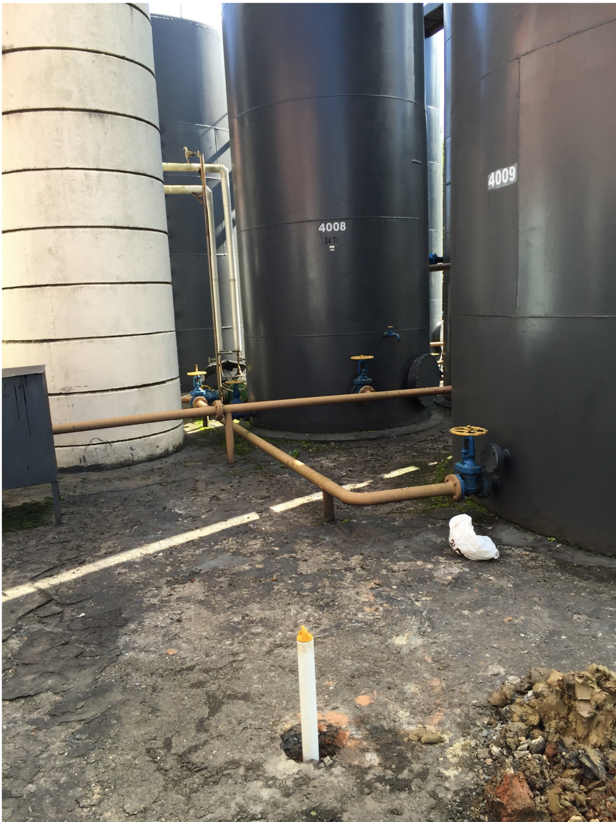
Figura 12. Evidência visual do poço de monitoramento provisório (PMP-01), instalado na área de produção da STRATURA, unidade de Campo Largo – PR.
